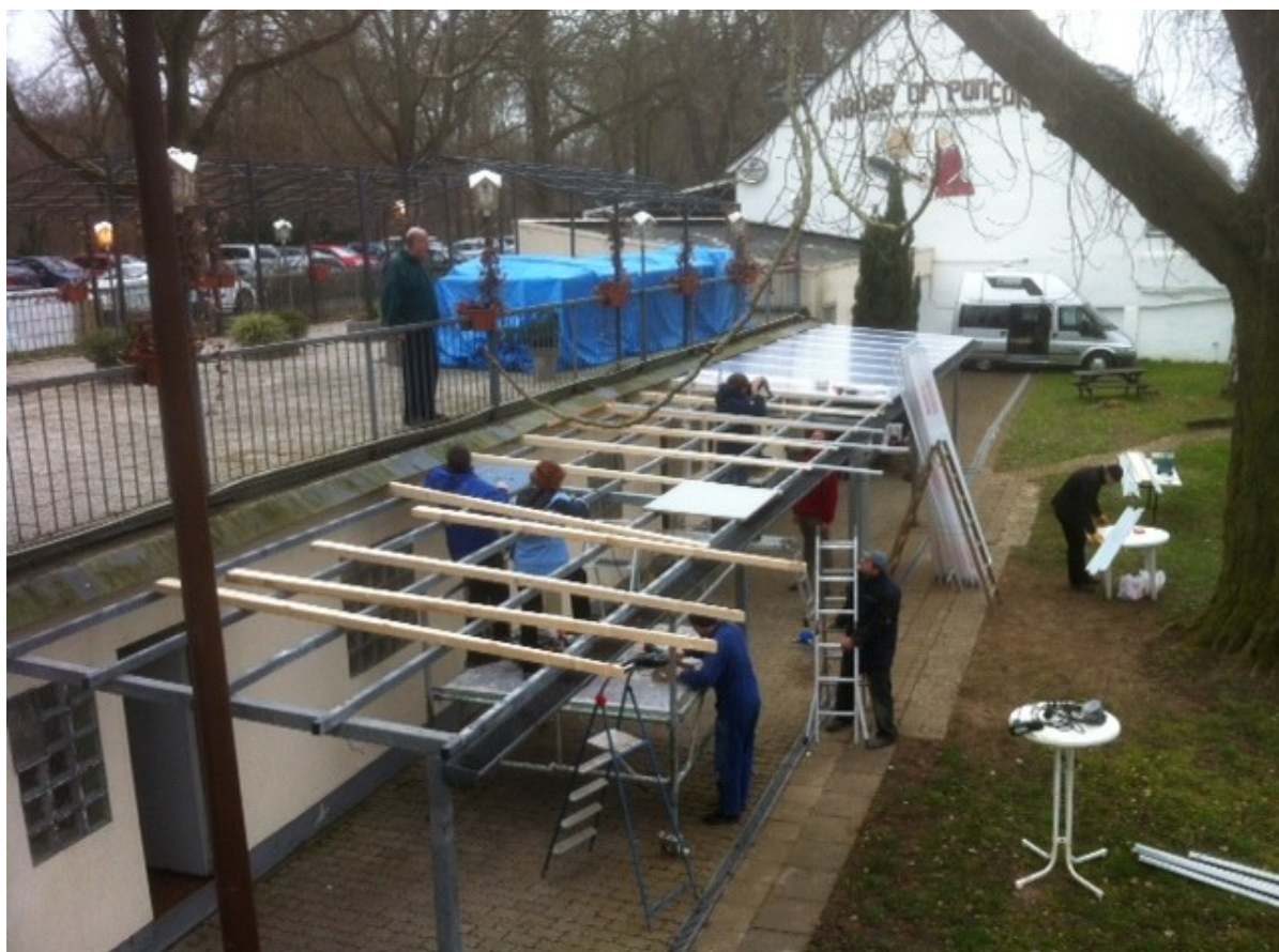
Bau des Schleppdaches im Frühjahr 2016
